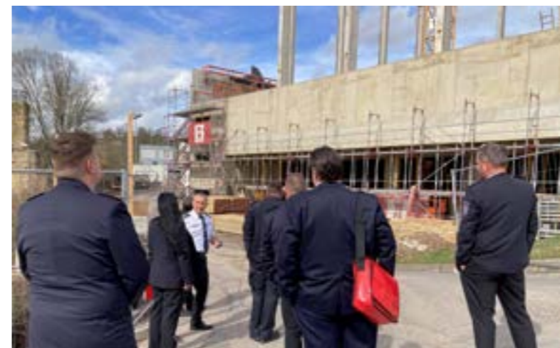
TLFKS: Schulleiter Jörg Heinze zeigt Fortschritte beim Bau neuer Gebäude (Bild: ThFV)
