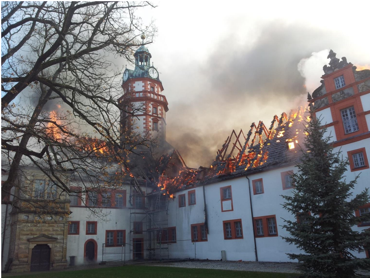
Abb. 16: Ausbreitung des Brandes nach ca. 15-20 Minuten (Quelle: LRA Gotha)
