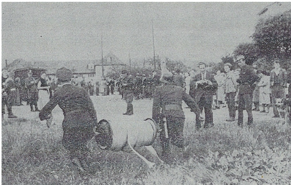
Die Schlauchverlegung auf westlicher Seite
