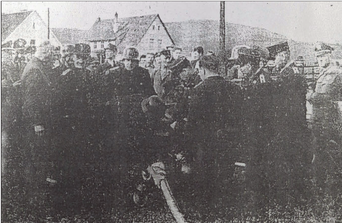
Der 600 m lange Schlauch wird an die Tragkraftspritze im Westen angekuppelt
